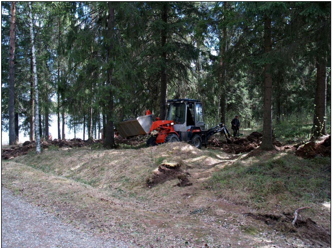
Kuva 11. Kiuruvesi Mäntyniemi kaava-alue. Konekaivuu käynnissä.
